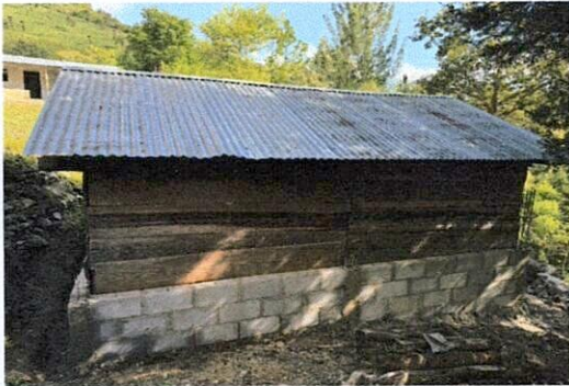
Foto 3: Mejoramiento de cocina.
